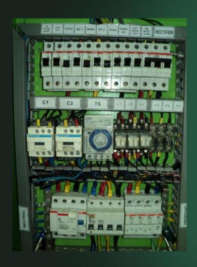
ACPDB merupakan singkatan dari Alternate Current Power Distribution Box. Kotak distribusi ini membagi arus kebeberapa peralatan seperti Rectifire, Air Conditioner, lampu indoor, lampu outdoor, socket outlet. ACPDB tersusun atas beberapa komponen elektronika diantaranya MCB, Kontaktor, Timer, Relay, Fuse dan Thermostat.
